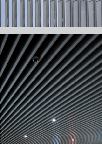
El Cielo Baffle es un cielo lineal que se instala uno al lado del otro mediante un portapanel variando su aspecto y separación de acuerdo al paso solicitado.
